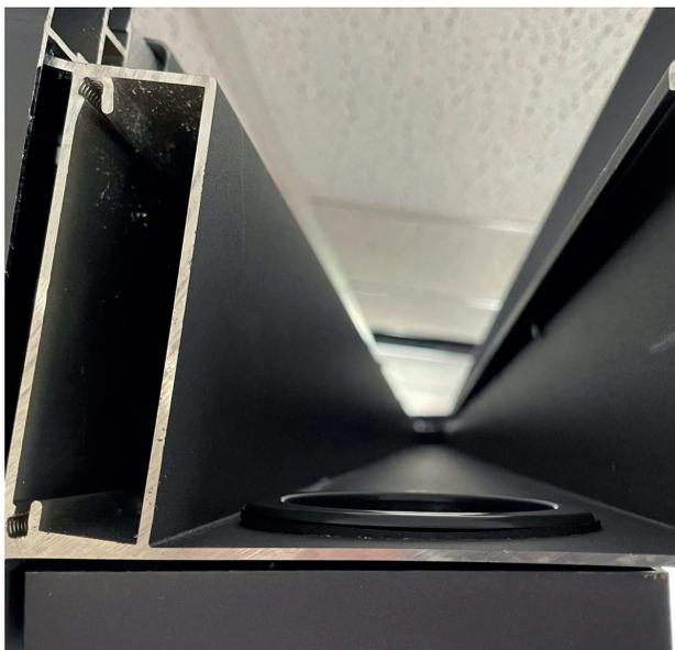
Entfernen Sie die Stütze an der Unterseite der Rinne. Schrauben Sie die Unterseite vorsichtig an den Abfluss. (Achten Sie darauf, dass Sie das Kunststoffgewinde nicht beschädigen.) Schrauben Sie diesen Teil des Ablaufstutzens nicht mit Gewalt an. Er sollte sich so weit wie möglich gleichmäßig anziehen lassen, bis er fest an der Rinne anliegt. Falls er sich nur schwer drehen lässt. Schrauben Sie ihn ab und beginnen Sie dann vorsichtig wieder von vorne.
